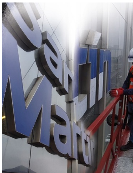
INSTALACIÓN EN FACHADA
